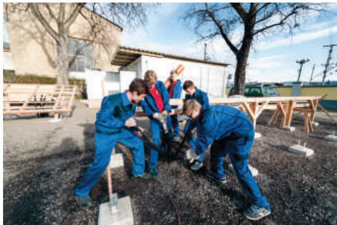
Verlegen der Leerschläuche für die PV-Dachanlagen
