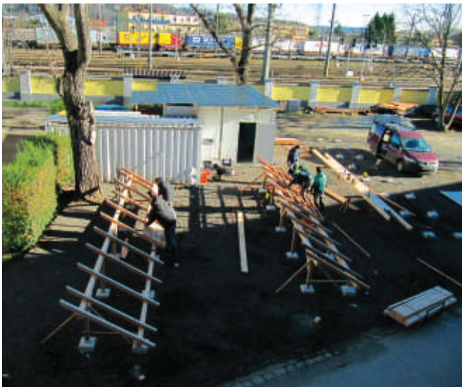
HTL-Ortwein unterstützt uns bei den Zimmererarbeiten
