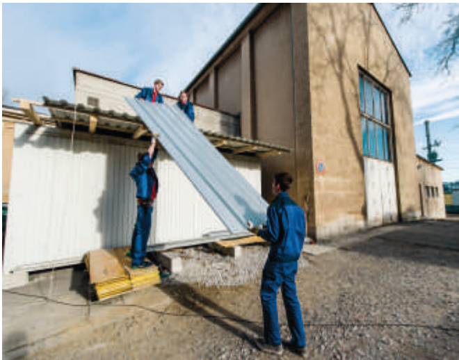
Die Container werden mit einem Trapezblech eingedeckt
